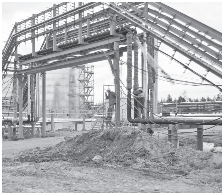
Теплотрасса г. Иркутск.
